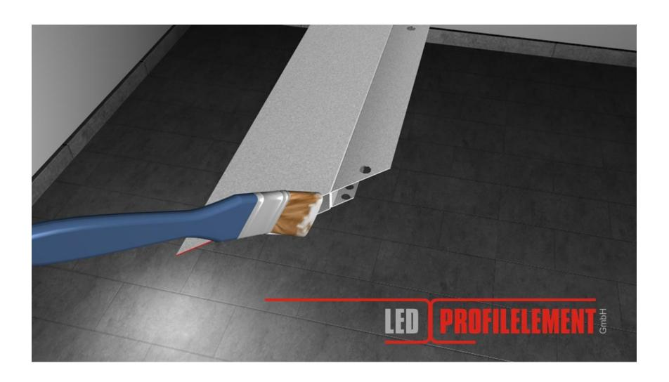
4. Öffnungen für die LED-Anschlussleitung mit einem Metallbohrer in das Profil von oben bohren
